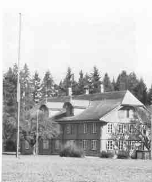
Poste d'essai installé à l'école de Schwarzenbourg
