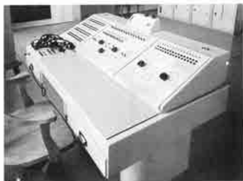
Le „cœur“ du service technique: Pupitre de contrôle dans la salle des amplificateurs
