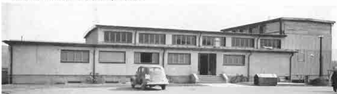
Nouveaux bâtiments et salle des amplificateurs
